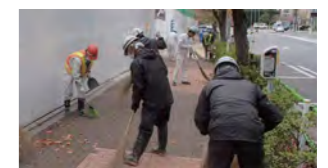
「(仮称)港区芝浦2丁目計画新築工事」での清掃の様子
