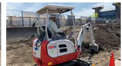
電動バックホーの採用(試験採用)
